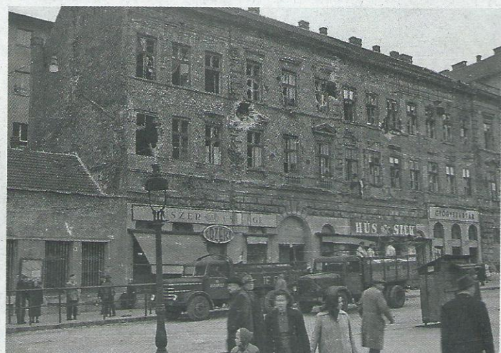
A Széna tér 1/a szétlőtt homlokzata
